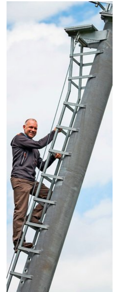
Geschäftsführer Samuel Wyssen auf einem Lawinensprengmast.
